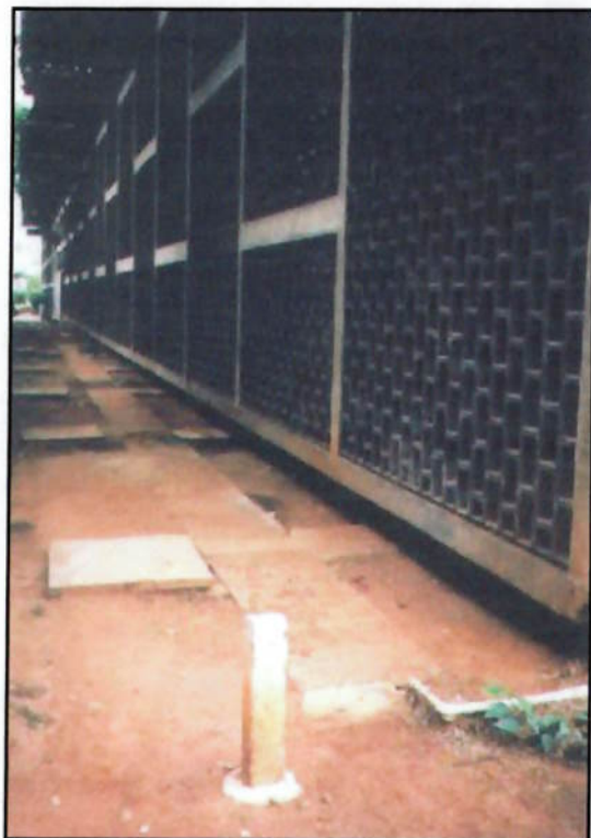
FOTO 9.3.2 - Caixas de decantação dos efluentes localizadas no LTM.
